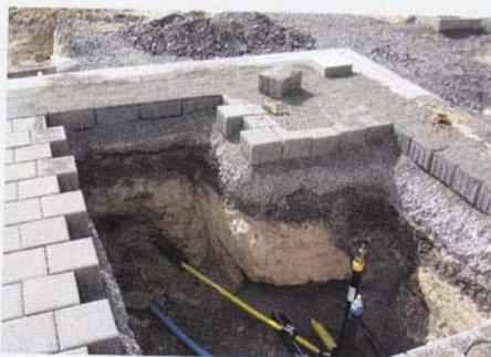
Speziell für den Stuttgarter Raum wurde ein Schichtenaufbau für Sickerpflaster entwickelt, der eine Versickerung von Regenwasser auch bei nur gering durchlässigen Böden ermöglicht. | Foto: Ingenieurbüro Diem-Baker
