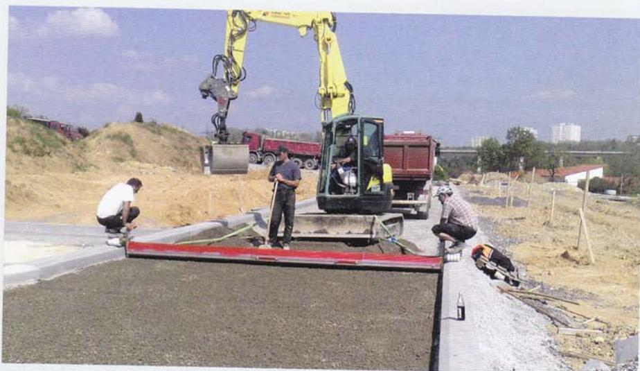
Aufbringen der Einkornbetontragschicht: Eine ca. 21cm dicke Schicht aus Magerbeton ist dank ihrer gleichförmigen Korngröße in der Lage, um die einzelnen Steine herum Wasser zu speichern. | Foto: Ingenieurbüro Diem-Baker
