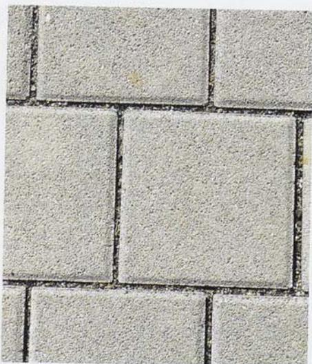
Relativ breite Fugen von 5 bis 7 mm, verfüllt mit einem Hartgesteinsplitt in einer Körnung von 2 bis 4 mm, sorgen für Stabilität in der Fläche. | Foto: Weller Marketing
