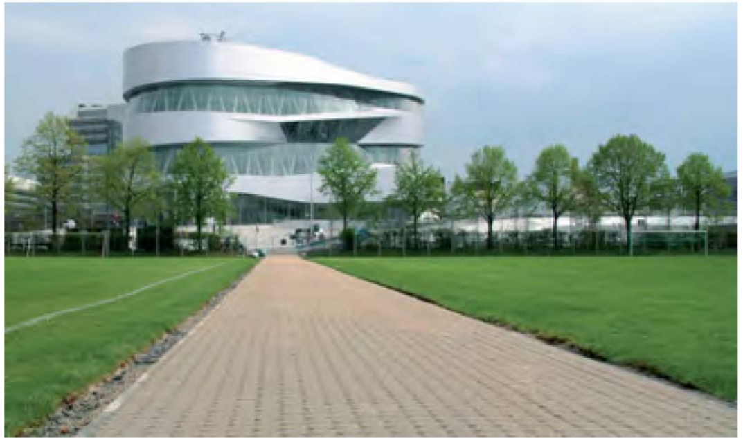
Auch die 400 Meter lange VIP-Zufahrt vor dem Mercedes-Benz Museum in Stuttgart wurde ökologisch befestigt. Zum Einsatz kam der UNI-Ökostein, der sich bereits seit Ende der 90er Jahre mit über 70.000 m 2 auch auf dem Cannstadter Wasen in Stuttgart bewährt hat. Foto: Adolf Blatt GmbH & Co. KG, Kirchheim am Neckar
